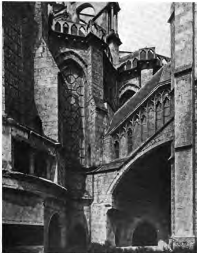
Fig. 96. — Escalier de la chapelle Saint-Piat, porté sur un arc. (Cathédrale de Chartres).
